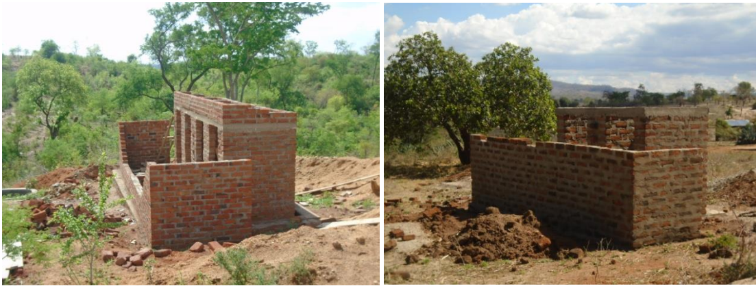
Sanitaire voorzieningen in aanbouw, Kwekivu Kilindi
